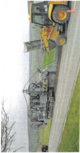
Photo 9 : Entierement de ligne électrique
